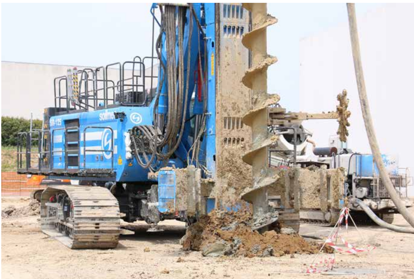
✓ PARTICOLARI DELLA PERFORATRICE SOILMEC SR-125 HIT IN FASE DI SCAVO
