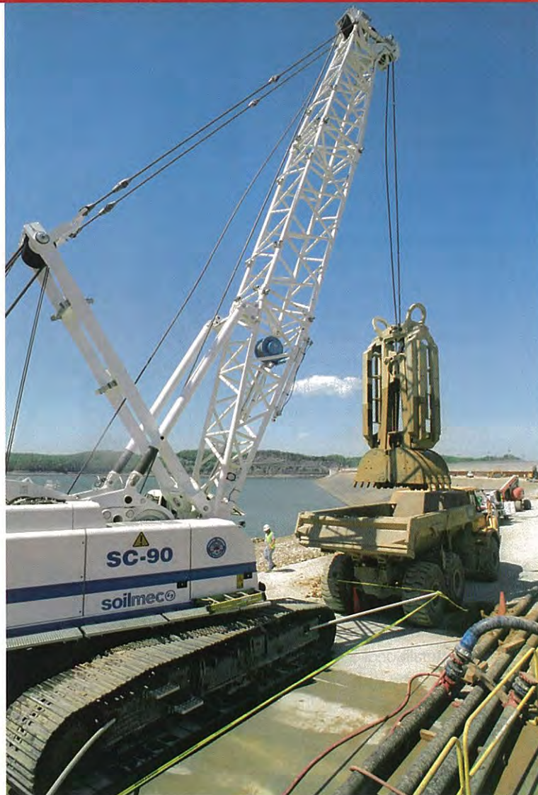
La SC-90 durante le operazioni di scavo a Wolf Creek Dam (Kentucky)
