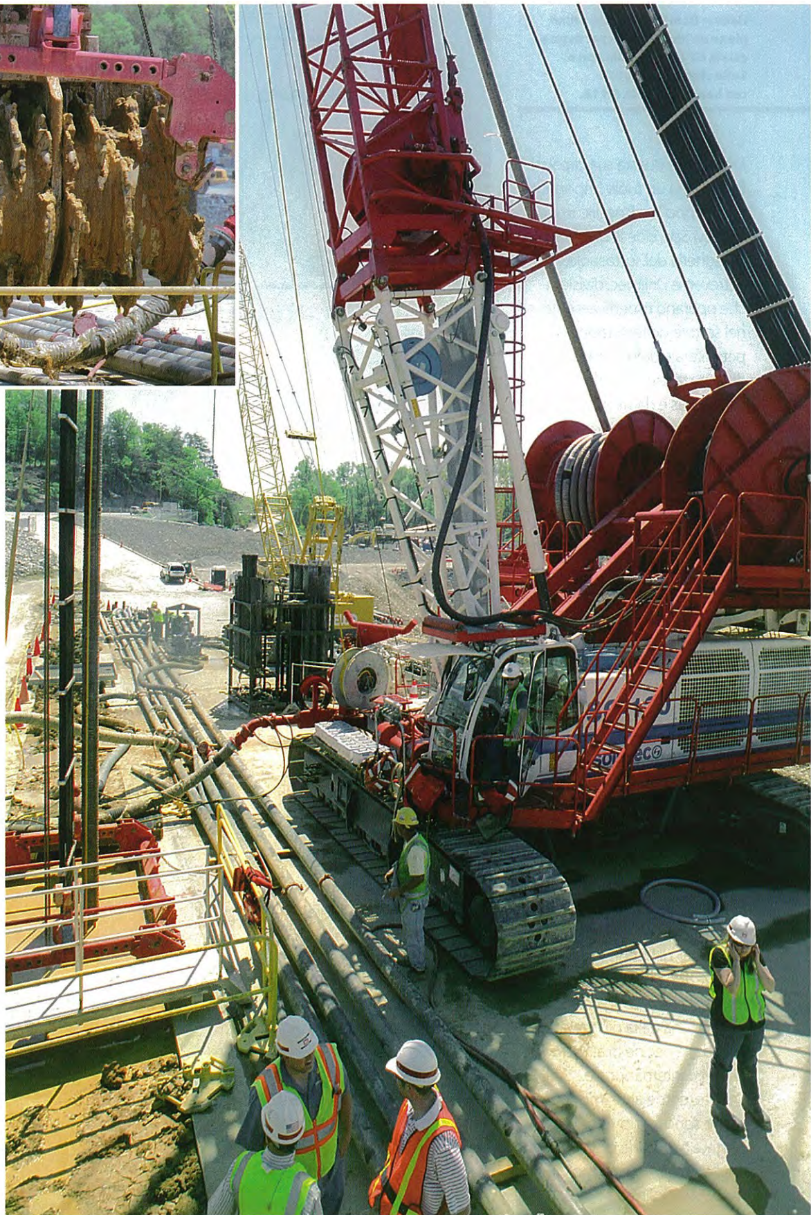
La SC-120 con idrofresa durante le fasi di scavo a Wolf Creek Dam (Kentucky)
