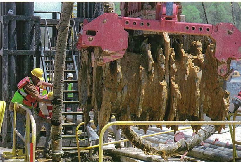
La SC-120 con idrofresa durante le fasi di scavo a Wolf Creek Dam (Kentucky)
