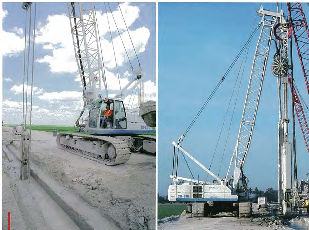
La SM 870 e la benna BH 12 hanno garantito alte produzioni e una perfetta verticalità dello scavo
