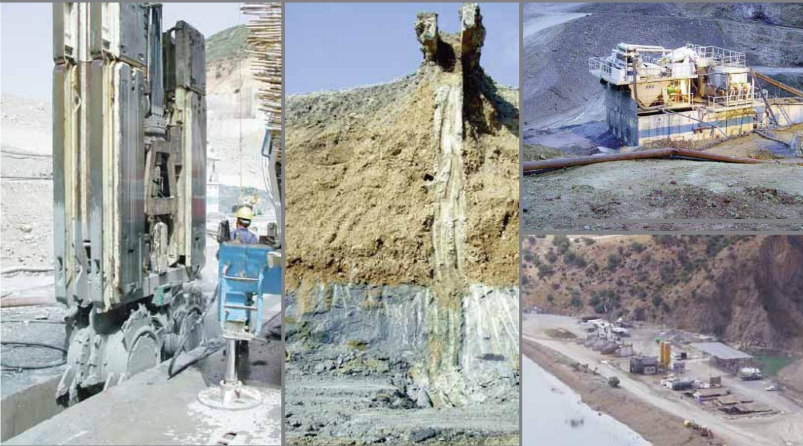
Lo spessore del modulo fresante è variato aggiungendo distanziali alle guide e sostituendo i tamburi. In questo caso si sono usate le ruote da 800 mm e la lunghezza del modulo fresante da 2800 mm.
