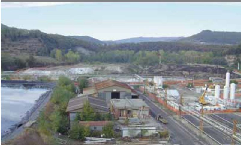
IMPIANTO CANTIERE / PLANT
