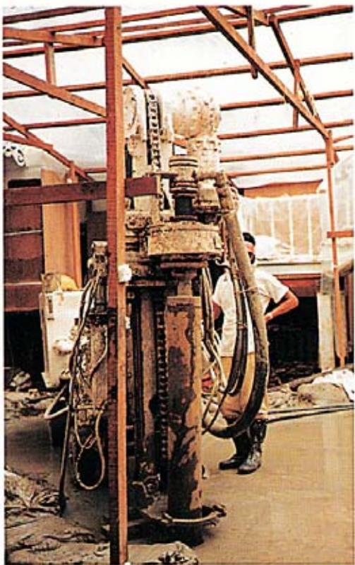
Durante la prima fase dell'iniezione la miscela è stata pompata tramite la valvola di non-ritorno più bassa in modo da formare un collare protettivo lasciato poi indurire dalle 10 alle 15 ore. È seguita l'iniezione della miscela della seconda fase ad una pressione di 12 atm. che ha rotto il primo collare di miscela. Il vuoto interno al tubo è stato lavato e riempito con miscela sotto pressione.
